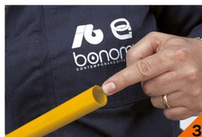
**Verificare** la corretta svasatura ed **eliminare** i residui di materiale che potrebbero **danneggiare** gli O-rings di tenuta.
