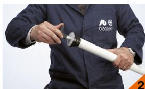
Calibrare con cura l'estremità del tubo usando l'apposito calibratore-svasatore.
