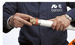
Inserire il tubo nel raccordo fino alla battuta con la rondella portabussola, **assicurarsi** che il tubo sia nella posizione corretta grazie ai fori della bussola. **Evitare assolutamente l'utilizzo di raccordi visibilmente danneggiati.**
